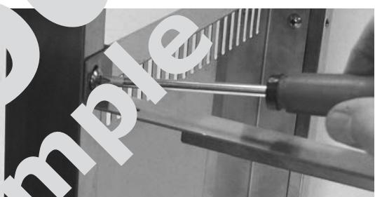
15. POSMS. Piestipriniet durvju konstrukciju durvis ar mazajām slēžuvām un paplāksnēm.
